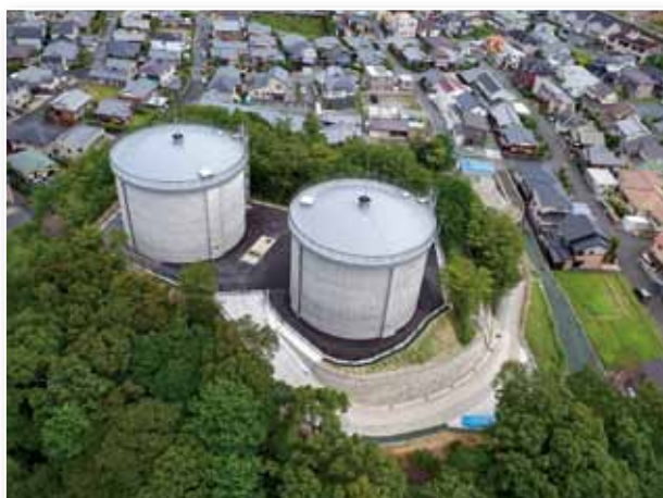
施設の耐震化・更新（勢田配水池）
