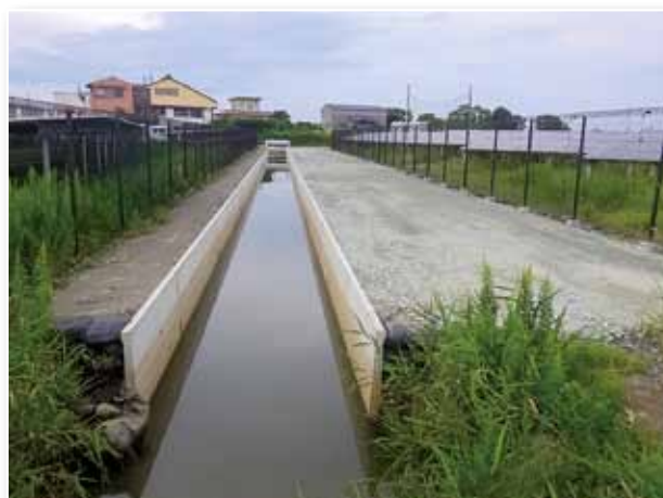
排水路の整備（大湊排水路）
